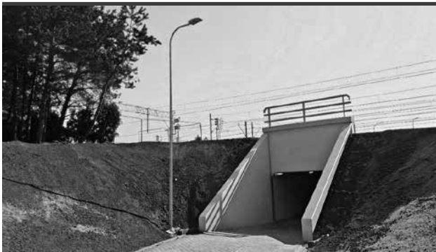
Przejście pod torami na ul. A. Krzywoń.
